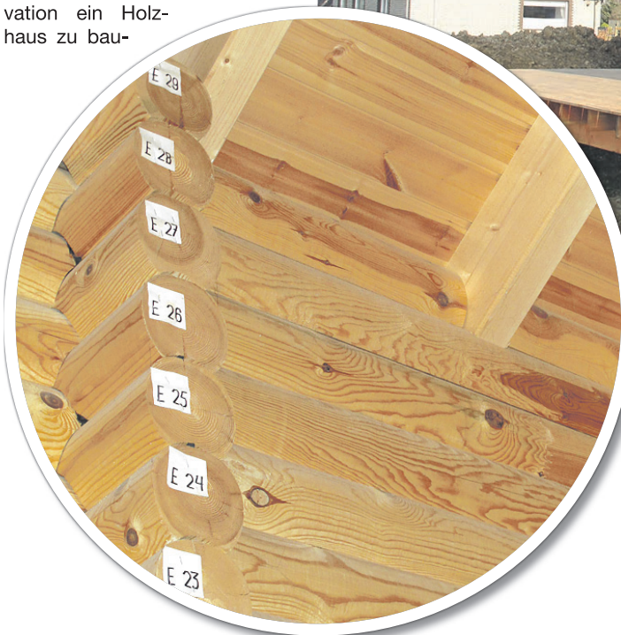
Die Balkenlage ist eindeutig nummeriert (links), damit die Montage vor Ort schnell von der Hand geht. Foto: rcl
