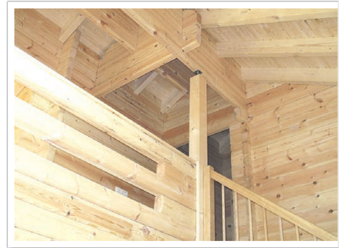
Freier Blick vom Erdgeschoss bis in das obere Stockwerk.
